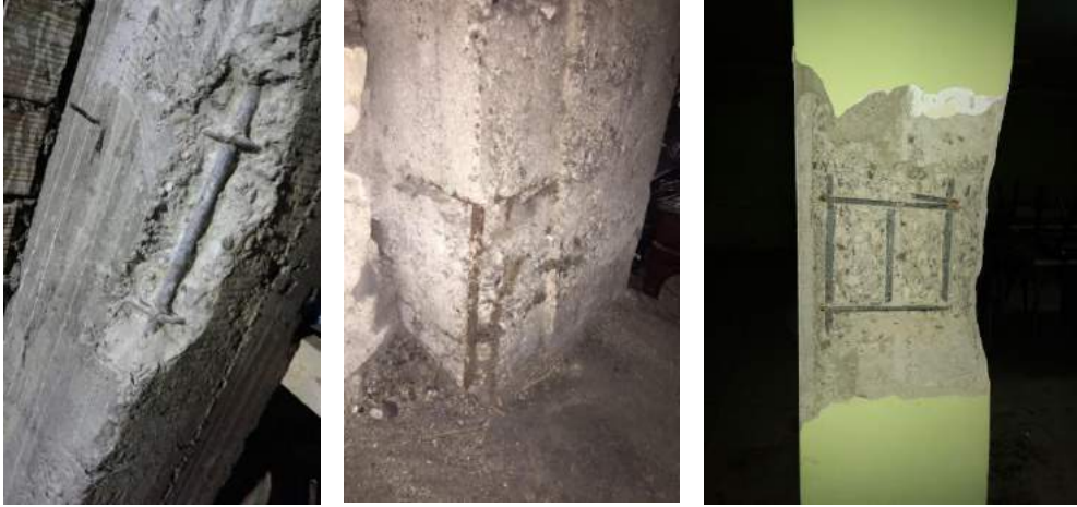
Şekil 6. Nervürsüz donatı (S220) ve Etriye aralıkları
