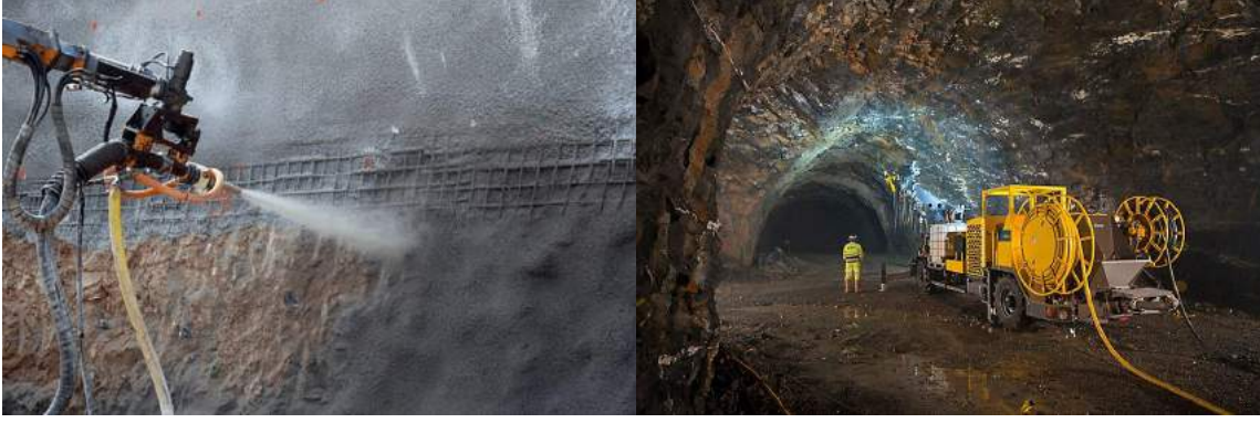
Şekil 2. Püskürtme beton uygulaması
