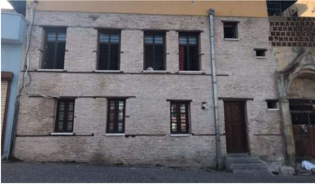
Şekil 5. Geleneksel Konutlarda Cephe düzenlemesi ve Hafifletme Kemerleri
