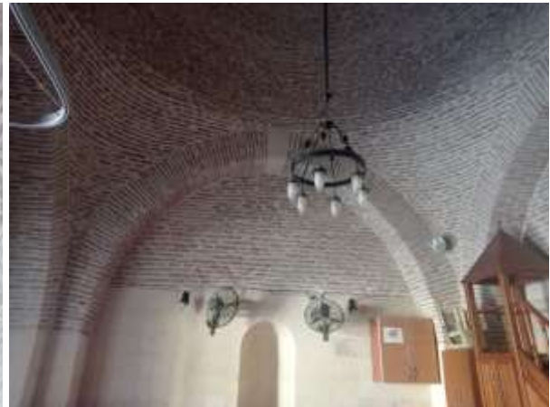
Şekil 11. Hasır Pazarı Camii Kemerler ve Kubbede Tuğla Kullanımı
