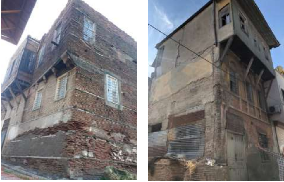
Şekil 1-2. Geleneksel Konut Örneklerinde Tuğla Malzeme kullanımı (Yazar Arşivi)
