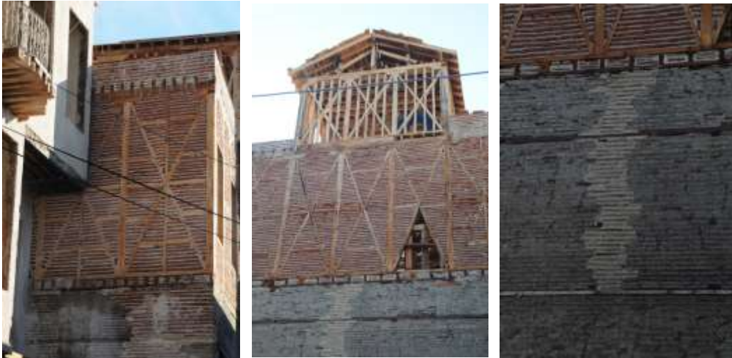
Şekil 4. Geleneksel Konutlarda Düz Tuğla Örgü ve Dolgu
