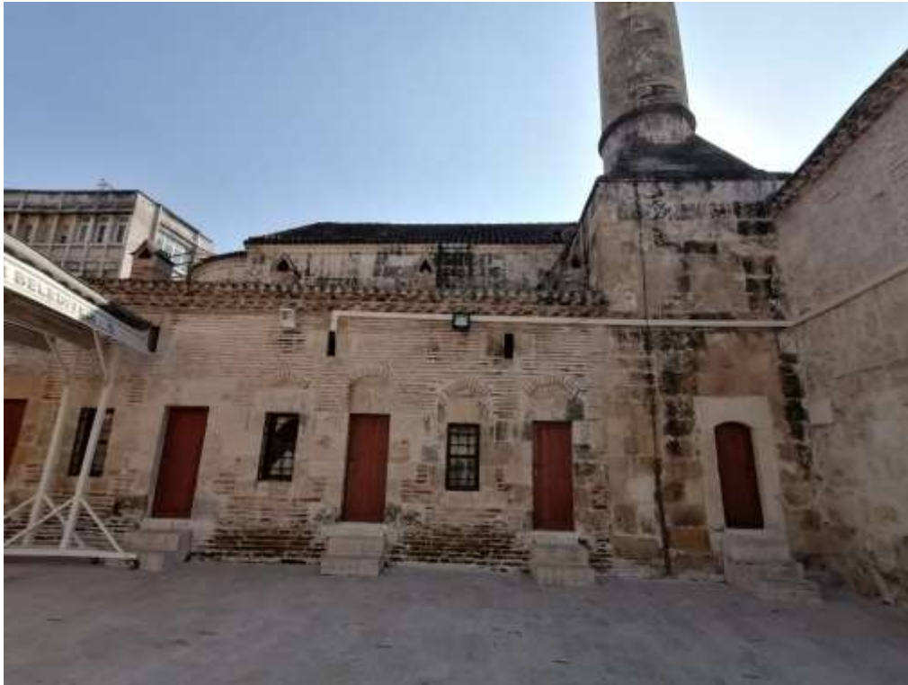
Şekil 8. Tepebağ Yağ Cami Taş ve Tuğlanın Birlikte Kullanımı
