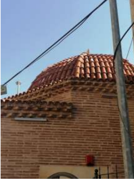
Şekil 9. Tepebağ Bakımoğlu Mescidi Saçaklarda ve Beden duvarında Tuğla Kullanımı
